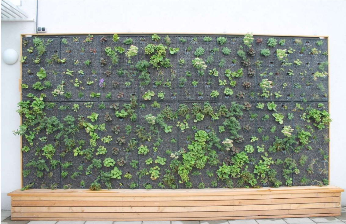
Abbildung 19: Kassettensystem im BRG 15 – Diefenbach Gymnasium kurz nach der Bepflanzung im Sommer 2017
