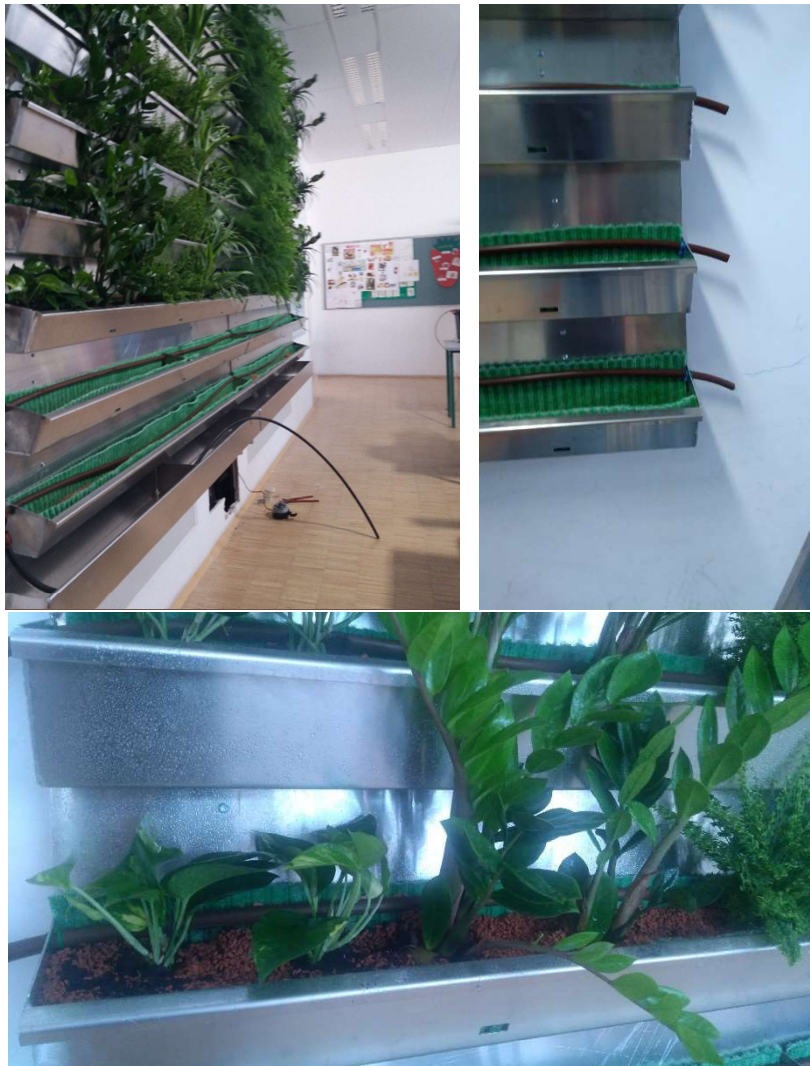
Abbildung 21: Installation des Bewässerungssystems im Trogsystem
