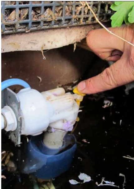
Abbildung 22: Pumpe im Wassertank beim Kassettensystem außen (links); Wassertank unter dem Trogsystem innen (rechts)
