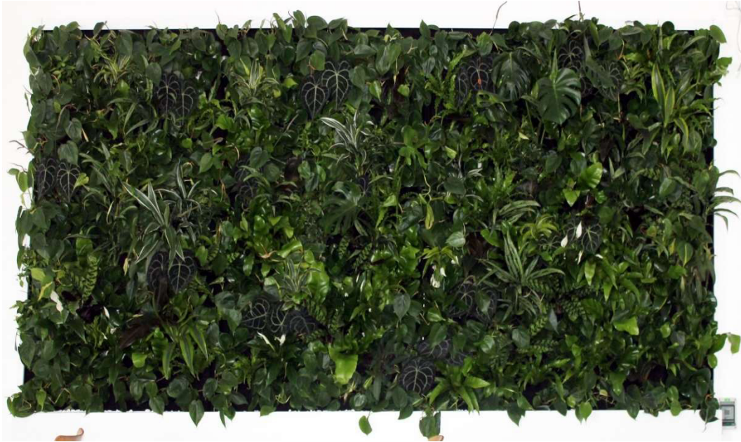
Abbildung 15: Vliessystem im Innenraum, BRG 16 Schuhmeierplatz
