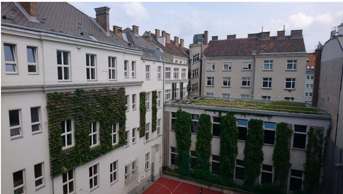
Abbildung 5: Dach- und Fassadenbegrünung GRG 7 Kandlgasse, 1070 Wien
